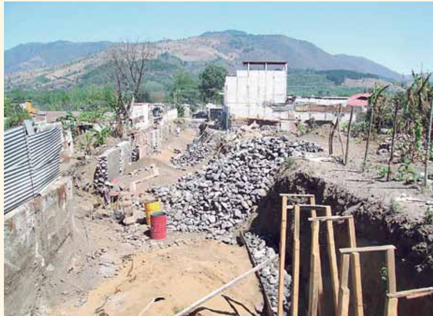
Miles de millones han sido contratados para invertir en obra pública, pero los resultados no se ven.
